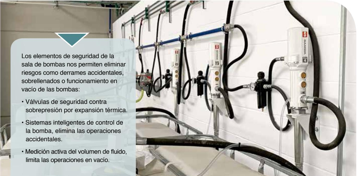
Los elementos de seguridad de la sala de bombas nos permiten eliminar riesgos como derrames accidentales, sobrellenados o funcionamiento en vacío de las bombas:
